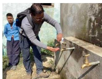
Réservoir d'eau école Masrangi
