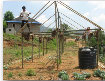
Construction d'un tunnel à tomates
