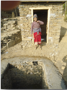
Toilette et fosse septique
