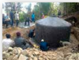
Réservoir d'eau en construction
