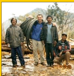
Installation de tuyaux dans le village de Syauri (Sur la photo avec les népalais, Jean Gosselin de CQN)
