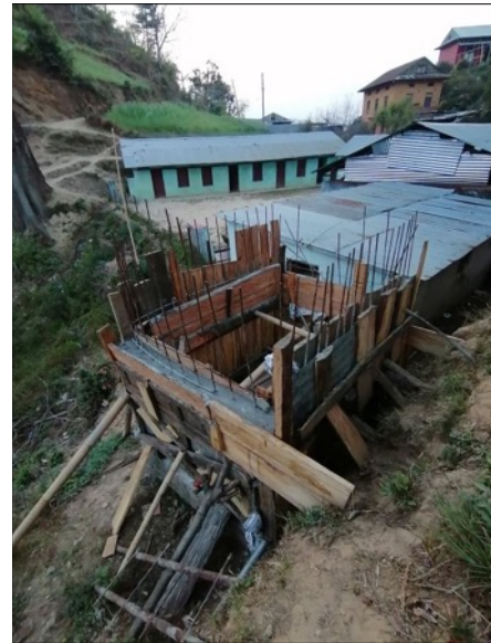
Construction du réservoir du stockage pour l'école de Masrangi
