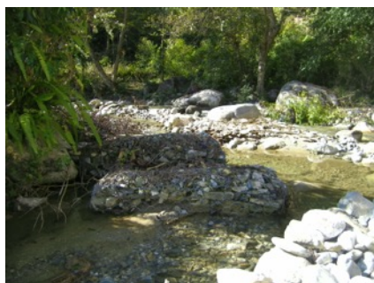
Murets pour canaliser l'eau vers un réservoir de captation
