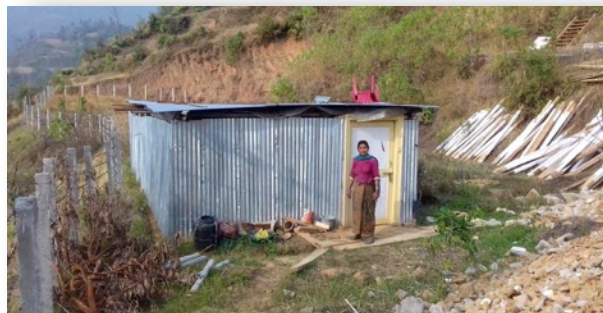
Entreposage des biens du Centre en attendant la reconstruction
