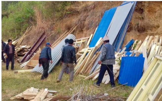
Démolition du Centre communautaire et la récupération des matériaux
