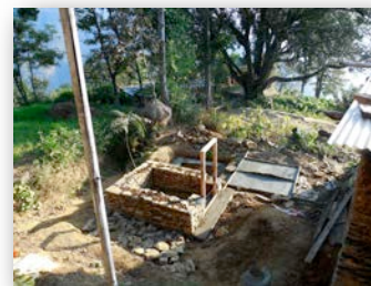
Toilette et fosse septique en construction
